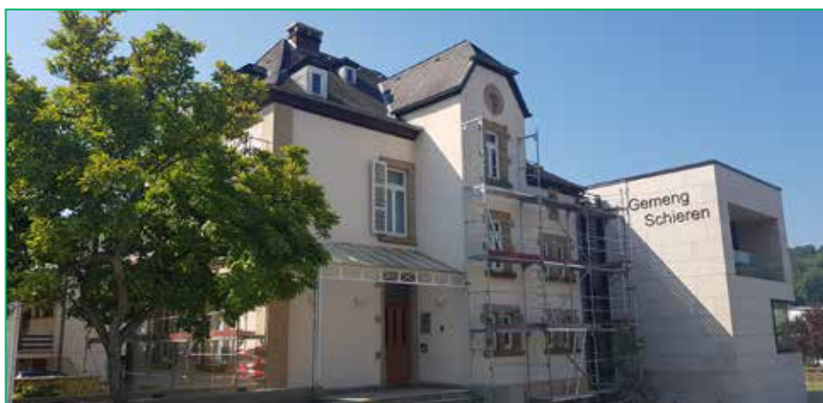
Fassadearbechten um Gemengenhaus
