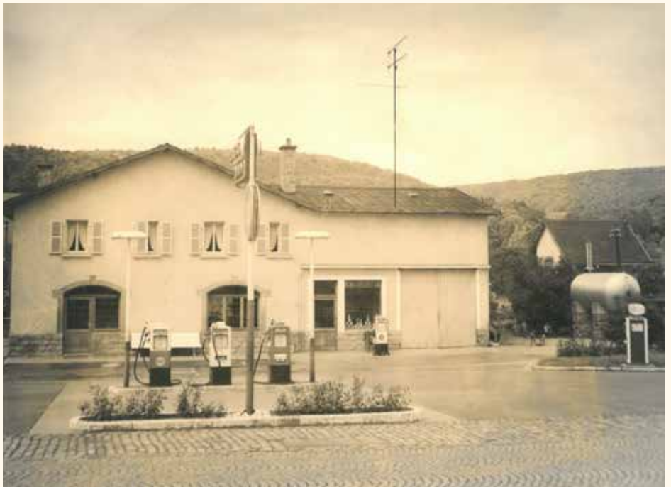
D'Gulf-Tankstell an den éischte Joere mat dem Gastank ganz riets. D'Haus war en Deel vun der fréierer Rousenziichterei Meisch
