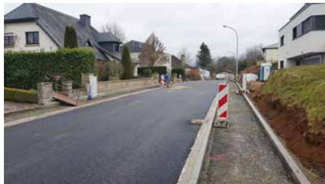
Chantier Rue Jean-Pierre Schuster
