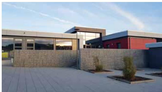
Gabione bei der Schoul
