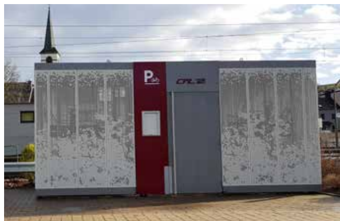
M-Box an der Rue de la gare
